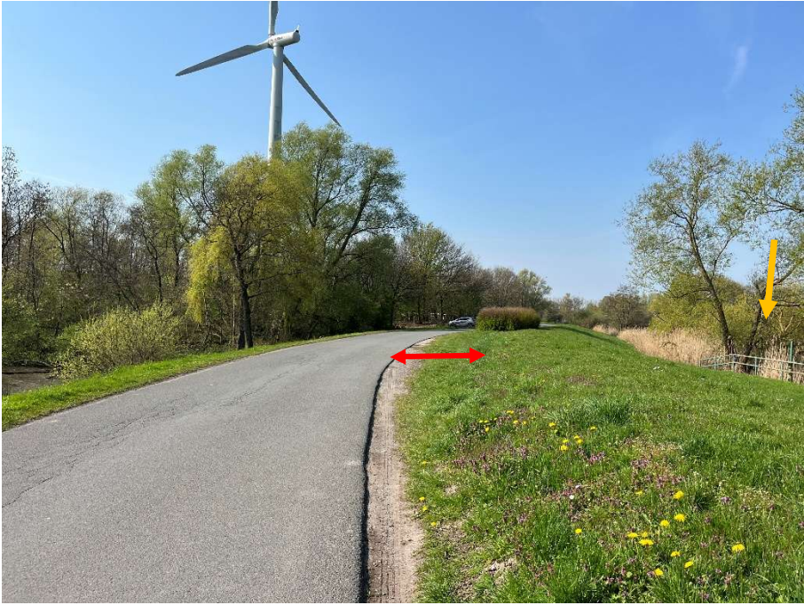
Abbildung 2: Lesumdeich mit Berme (rot) und Sielbauwerk (Blickrichtung Westen)
