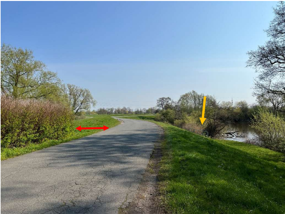
Abbildung 3: Lesumdeich mit Berme (rot) und Sielbauwerk (Blickrichtung Osten)
